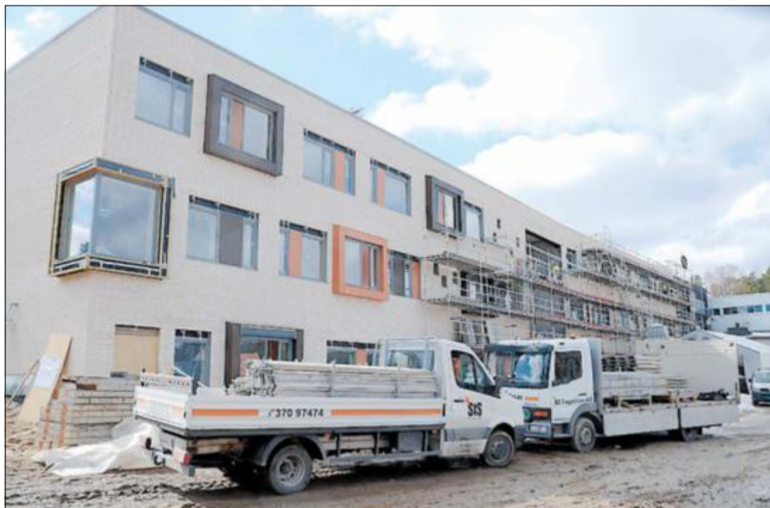
REISER SEG. Og slik ser det ut når stillasene kles av den ene ytterveggen og den nye fasaden blir mer og mer synlig. Dette er baksiden av bygget og der hovedinngangen kommer.
