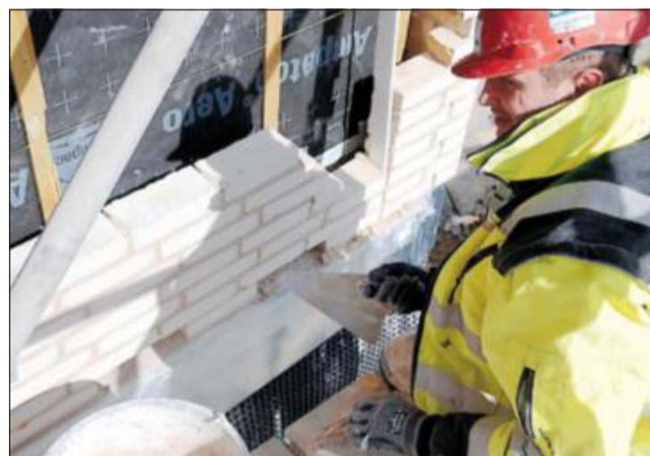
MURER. Nå om dagen har murerne en stor jobb med å kle hele bygget med hvite stein.
