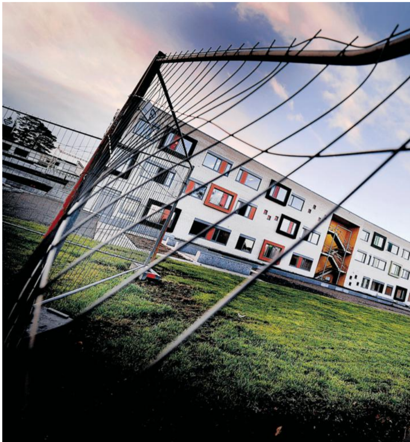
Foreløpig er nyskolen bak dette gjerdet, men snart skal lokalbefolkningen få ta i bruk den nye storstua.
